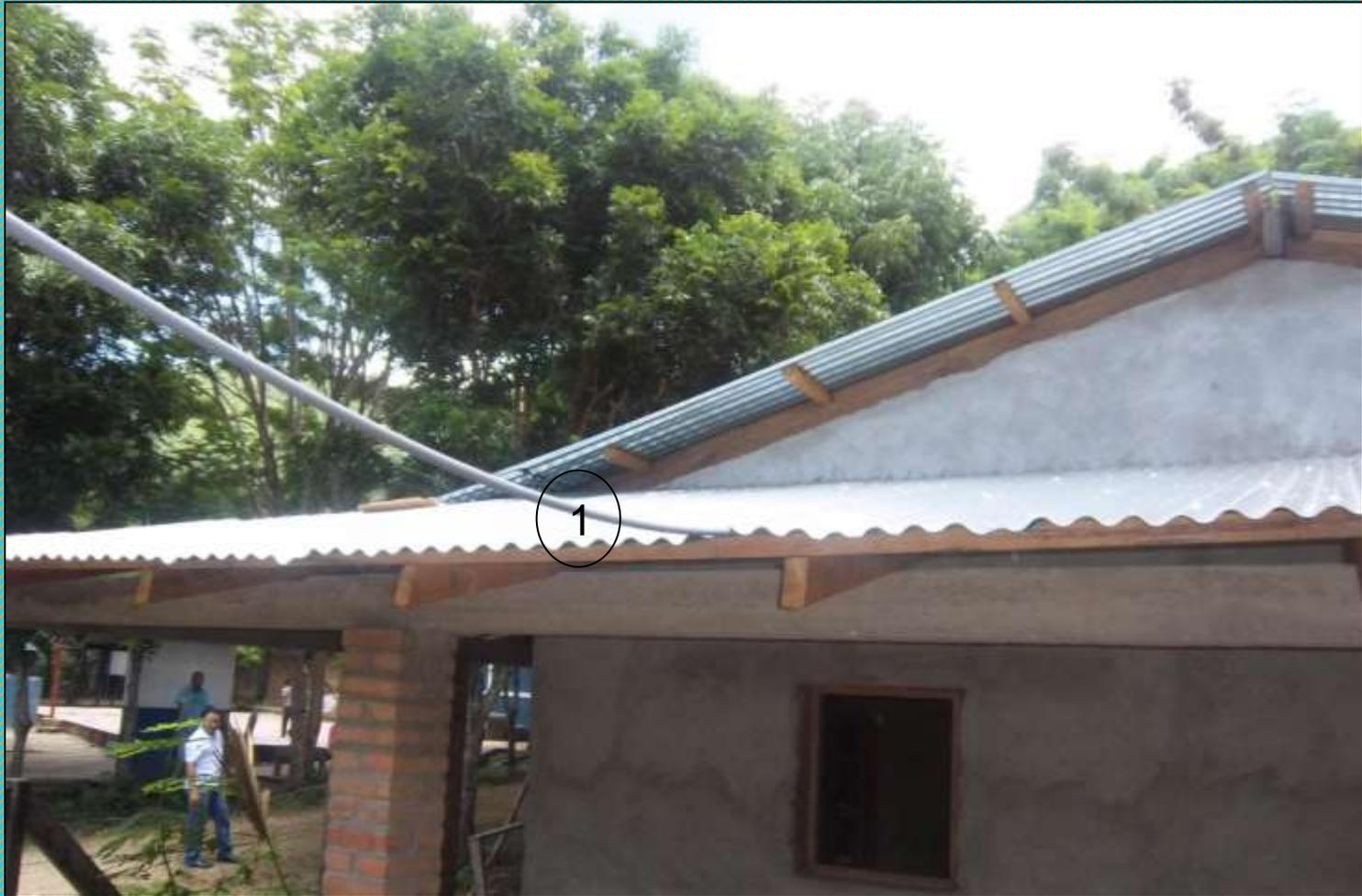
Tras la colocación de las 2 nuevas placas solares en el puesto de salud se extiende un cable para abastecer a la casa materna. ①
